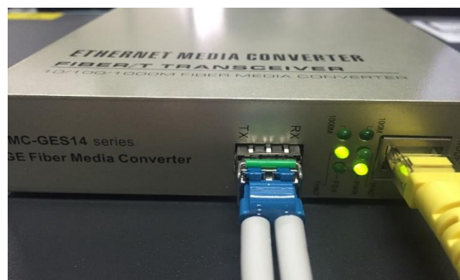
รูปด้านบน ไฟติด 2 ดวง แสดงสาเหตุเกิดจาก อุปกรณ์ Router ภายในสถานศึกษาเองมีปัญหา
