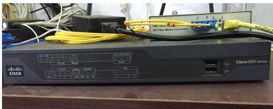
รูปด้านบน ไฟไม่ติดทุกดวง แสดงอุปกรณ์มีปัญหาาระบบจ่ายไฟ
