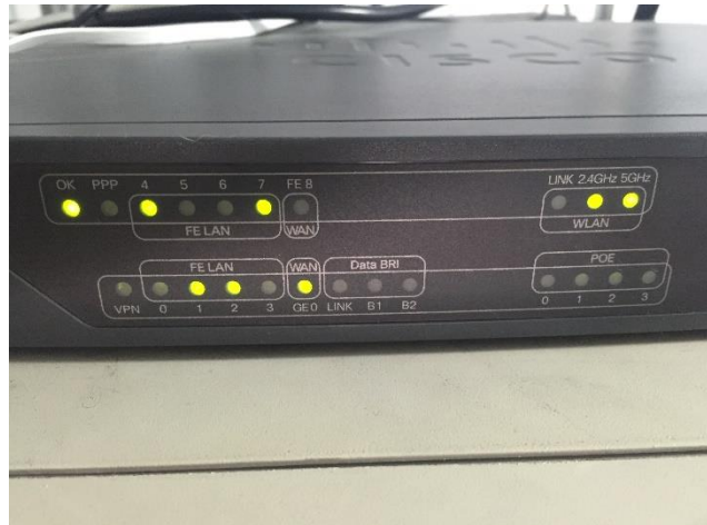
รูปด้านบน Router 892 ไฟติด แสดงสถานะปกติ
