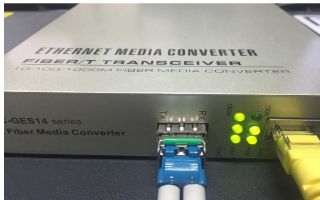
รูปด้านบน ไฟติด 5 ดวง แสดงสถานะปกติ
