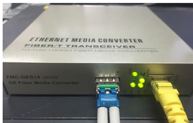
รูปด้านบน ไฟติด 4 ดวง แสดงสาเหตุเกิดจาก Fiber Optic ขาด หรือ สถานศึกษาต้นทางมีปัญหา ระบบไฟฟ้าหรือปิดอุปกรณ์
