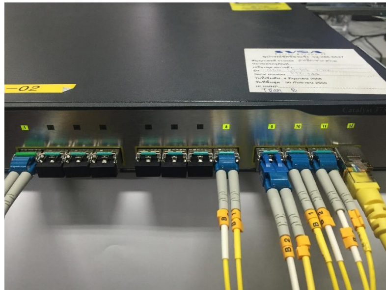
รูปด้านบน อุปกรณ์ Switch Cisco 3750 ไฟติด แสดงสถานะปกติ
