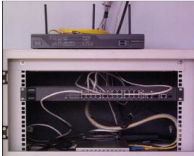
ภาพด้านบน แสดงตำแหน่งติดตั้งของอุปกรณ์ Router
