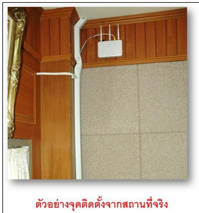
ภาพด้านบน จุดติดตั้ง Access Point จากสถานที่จริง
