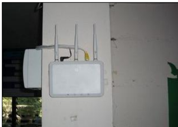
ภาพด้านบน แสดงตำแหน่งจุดติดตั้งของ Access Point
